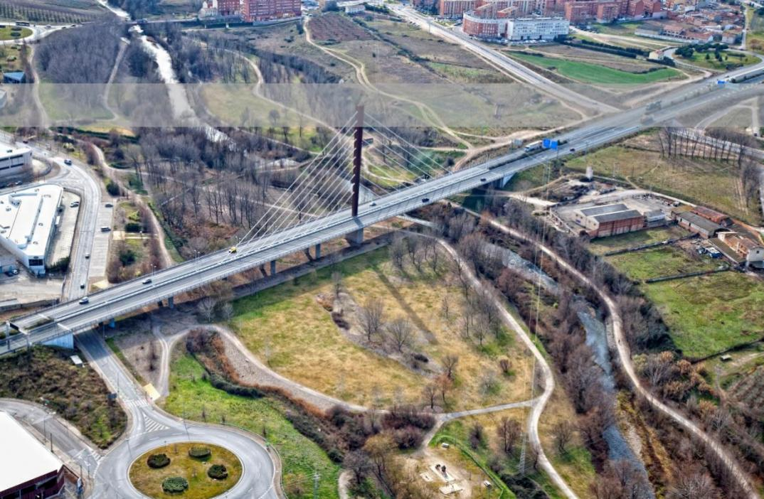
**Puente sobre río Iregua.** Atirantado tipo abanico de 120m de luz, con pilono metálico y tablero de hormigón. Forma parte del proyecto de autovía de circunvalación de Logroño de 7km de longitud. Obra contratada con la UTE Logroño Sur (Ploder, Azvi, Grupo Puentes, Sarrión) en el año 1999. Se ejecutó en 27 meses.
