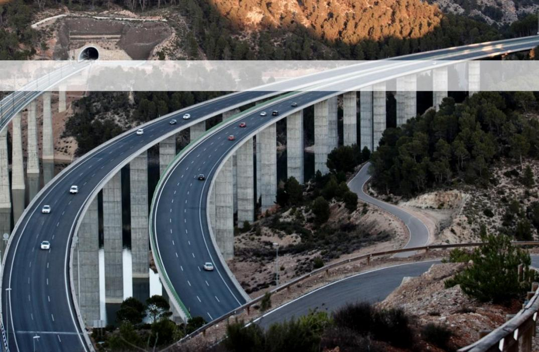
**Viaductos del Istmo.** Infraestructuras cuasiparalelas para autopista de 850m de longitud media, altura máxima 66m, ancho 14m y canto de 2,3m. Tableros en viga cajón ejecutados in situ con dos CCA en paralelo con un ciclo de siete días por vano; pilares octogonales huecos construidos con encofrado auto-trepante. Fueron contratados con la UTE Autovía N-III en 1997. Se ejecutaron en 12 meses.
