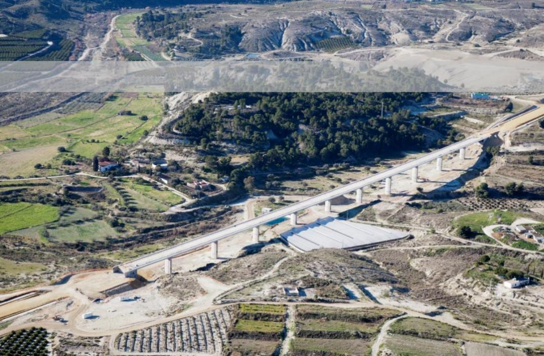
**Viaducto Almocaizar.** Infraestructura ferroviaria para alta velocidad de 534m de longitud. Estructura específicamente diseñada para resistir sismos con apoyos pendulares y tetones inferiores en zona de pilares. Contratado en 2010 con Sacyr para Adif. Se ejecutó en 12 meses.
