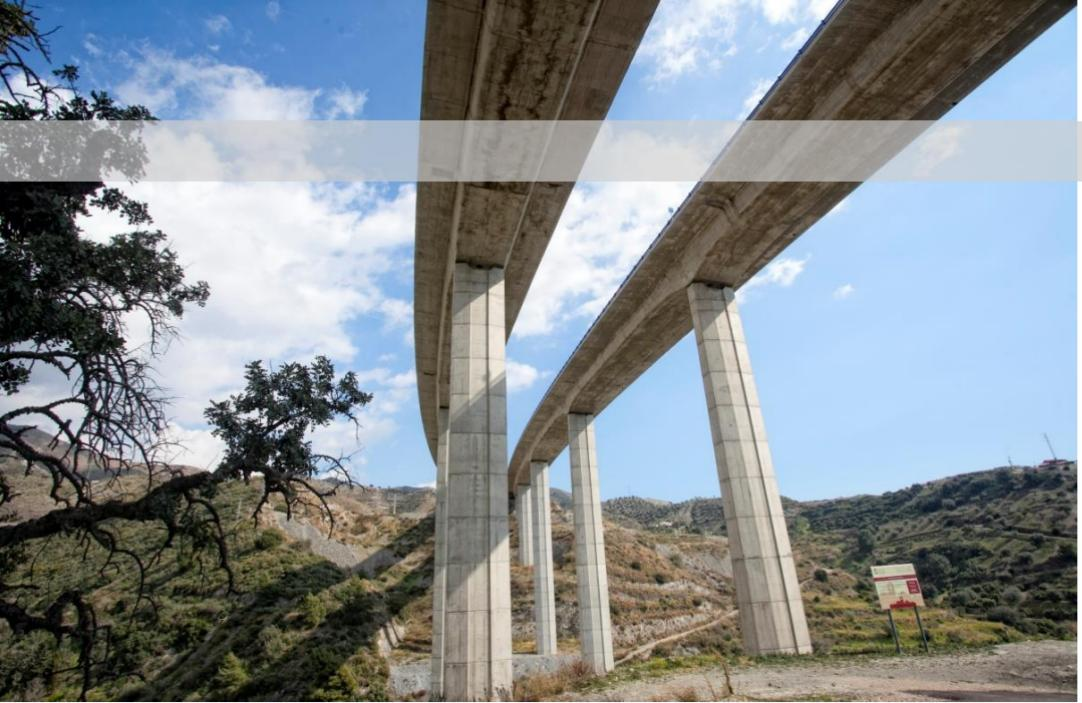
**Viaducto del Jate.** Infraestructura para carretera con doble tablero de losa continua en viga cajón de hormigón pretensado con canto variable, apoyado sobre pilares octogonales huecos, construidos con encofrado auto-trepante. Obra contratada con la UTE Herradura (Azvi, Ploder, Ossa) para el Ministerio de Fomento en 2004 y ejecutada en 12 meses.
