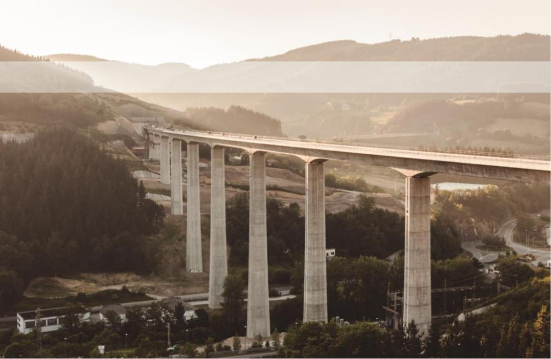
**Viaducto sobre el río Deba.** Infraestructura ferroviaria para alta velocidad de 900m de longitud. Tablero en viga cajón con vano de luz máxima 80m. Ejecutado en varias fases de hormigonado y tesado a fin de optimizar las cargas actuantes. Contratada con la UTE Bergara (Sacyr, Campezo, Cycasa, Febide) para Adif en 2013. Se ejecutó en 10 meses. *Récord de España por máxima luz de tablero de AVE ejecutado con cimbra autolanzable.*
