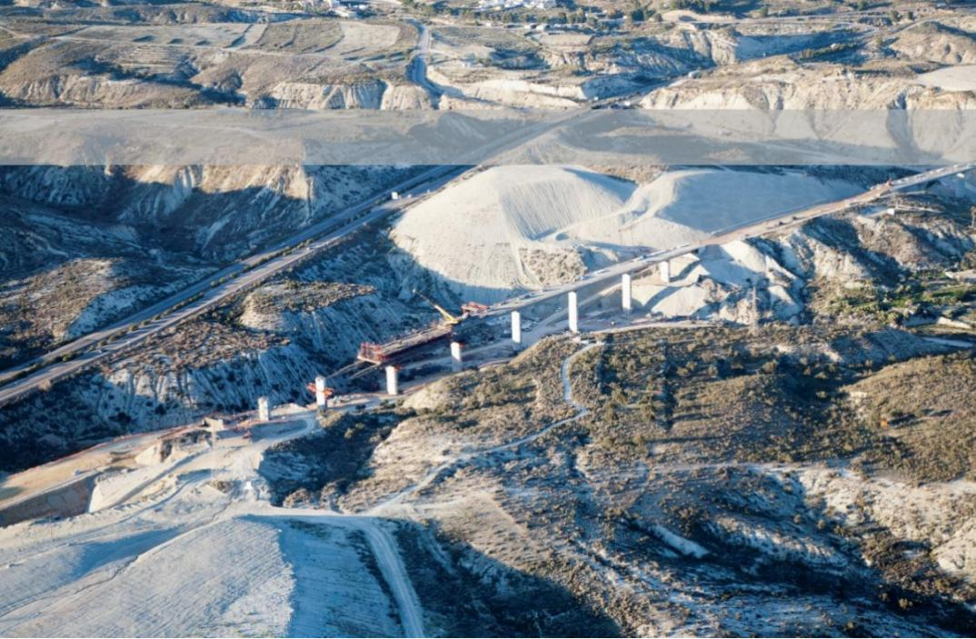
**Viaducto de los Giles.** Infraestructura ferroviaria para alta velocidad de 360m de longitud. Estructura específicamente diseñada para resistir sismos con apoyos pendulares y tetones inferiores en zona de pilares. Contratado en 2010 con Sacyr para Adif. Se ejecutó en 8 meses.
