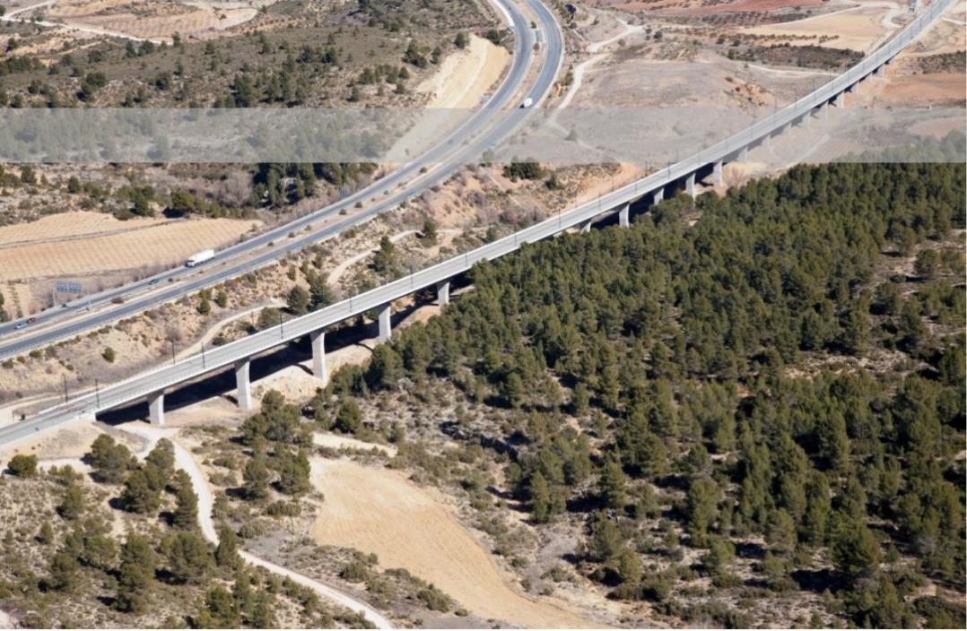
**Viaducto Arroyo de las Huertas de Mateo.** Infraestructura ferroviaria para alta velocidad de 995m de longitud, con pilares de sección variable. Tiene el punto fijo en uno de los estribos con un macizo de hormigón pretensado para resistir esfuerzos horizontales. Contratada en 2007 con la UTE Minglanilla (Coprosa-Puentes Infraestructuras) para Adif. Se ejecutó en 14 meses.
