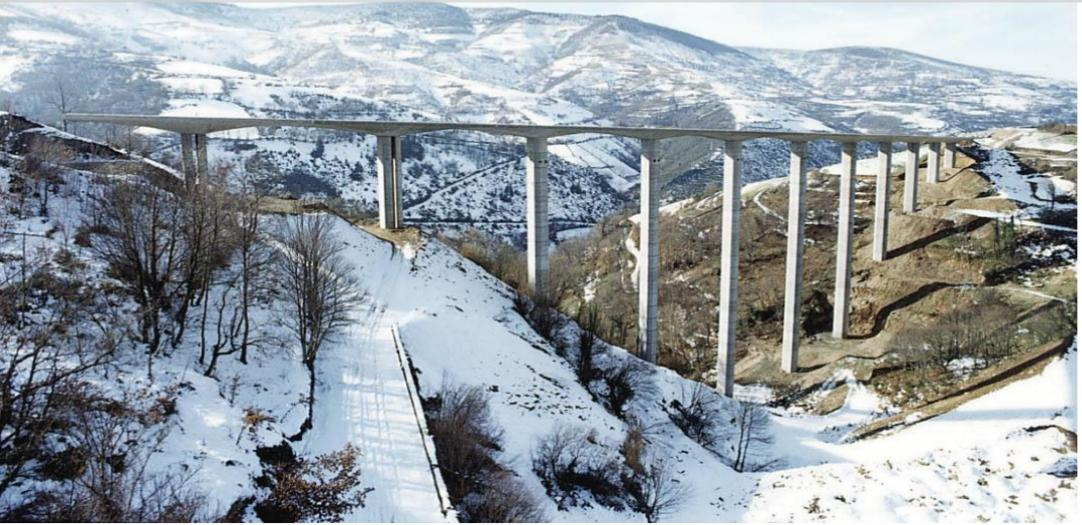
**Viaducto de Silvela.** Infraestructura para autovía de 410m de longitud. Pilares octogonales para sostener cada seta de 27 por 37m de losa, en hormigón armado. Construido por fases sucesivas con una cimbra autolanzable específica; con un ciclo de 15 días por vano. Vano máximo 37m. Obra contratada con la UTE Dycagro (Dragados, Ferrovial) en 1998. La duración de los trabajos fue de 14 meses.
