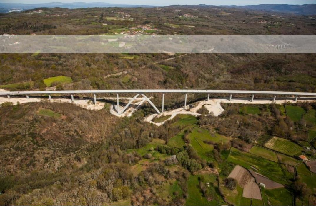
**Viaducto de Arnoia.** Infraestructura ferroviaria para alta velocidad de 802m de longitud y canto 3,65m. El punto fijo se materializó en un arco apuntado que se ejecutó mediante el abatimiento de los semiarcos. Contratado en el 2011 con UTE Miamán para Adif. Fue ejecutado en 13 meses.
