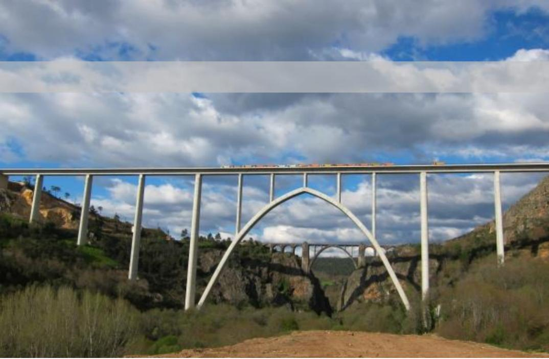
**Puente sobre el río Ulla.** Infraestructura ferroviaria para alta velocidad de 632m de largo, tablero en viga cajón, sobre un arco poligonal de 180m de luz y 120m de flecha, construido por dovelas en voladizo con atirantamiento provisional al tablero. Contratado con UTE Ulla para el Ministerio de Fomento en 2008. Ejecutado en 28 meses.
