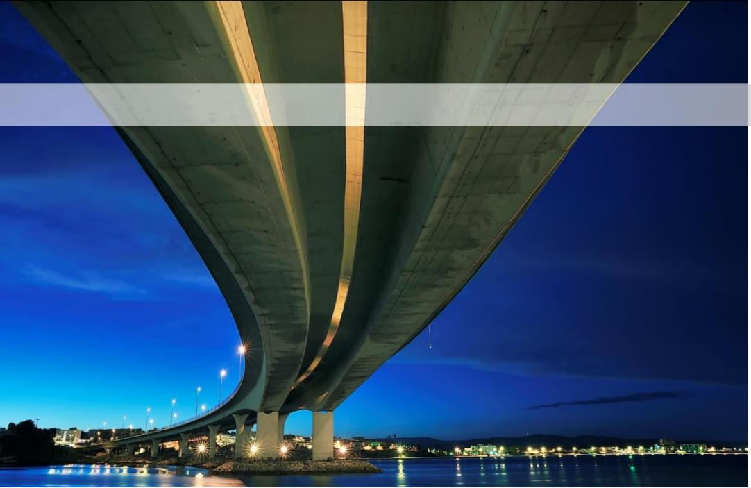
**Puente del Puerto de Algeciras.** Ejecución de los tramos terrestre y marítimo de la autovía para el Acceso Norte al Puerto de Algeciras. Incluye la construcción de este puente sobre la bahía de 850m de longitud con un vano central de 125m construido por voladizos sucesivos. Obra contratada con el Ministerio de Fomento en 1996. Plazo de ejecución 39 meses.
