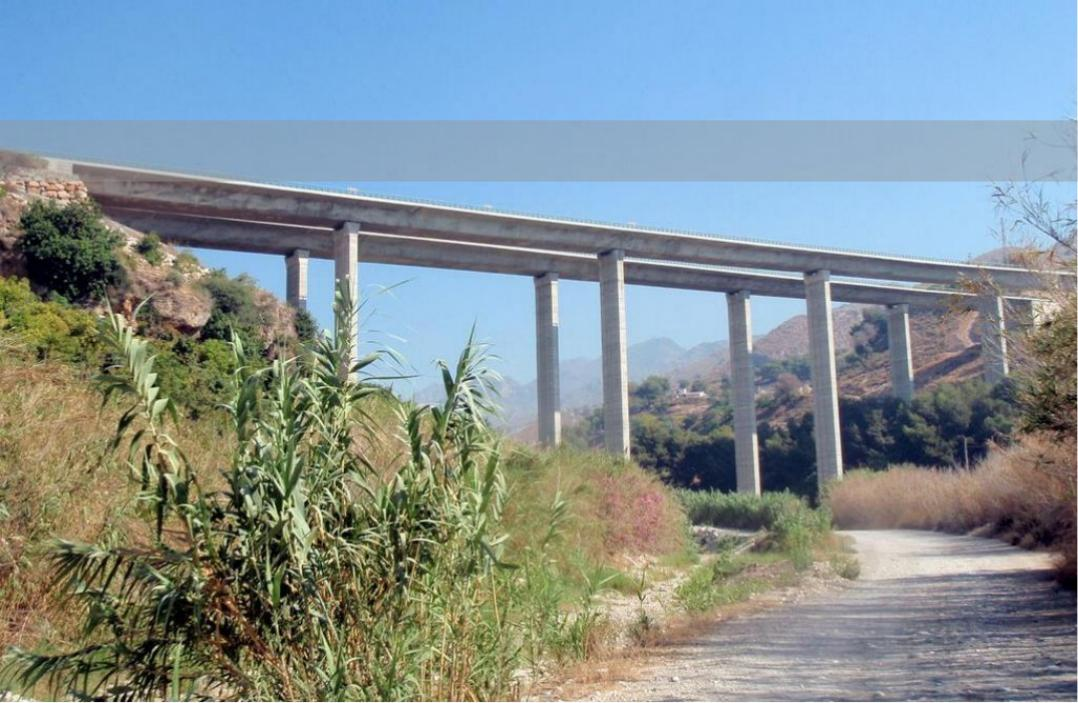
**Viaducto de Chillar.** Infraestructura de doble tablero para carretera con 13m de ancho y 242m de longitud. La fuerte pendiente (4%) y el acusado cambio de peralte (de -7.6% a 6.6%) dificultaron el avance y posicionamiento de la cimbra autolanzable. Contratada en 1999 con la UTE Necso-Entrecanales-Cubiertas. Se ejecutó en 13 meses.
