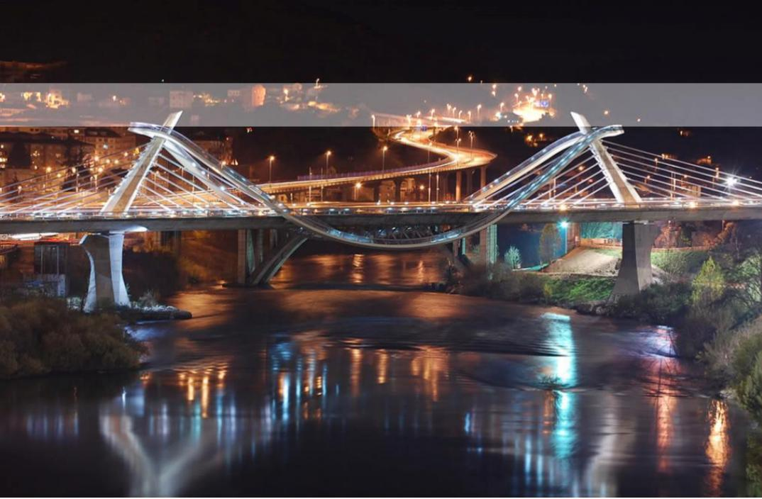
**Puente del Milenio.** Infraestructura para carretera y pasarela peatonal de 278m de longitud, atirantado y con pretensado extradosado inferior en centro de vano. De su tablero y pilares cuelga una pasarela peatonal abarquillada que permite acceder bajo la rasante del tablero y a los pilones. Contratada por UTE Miño (Dragados-Oca) para el Gobierno Autonómico en 1999. La duración de las obras fue de 19 meses.
