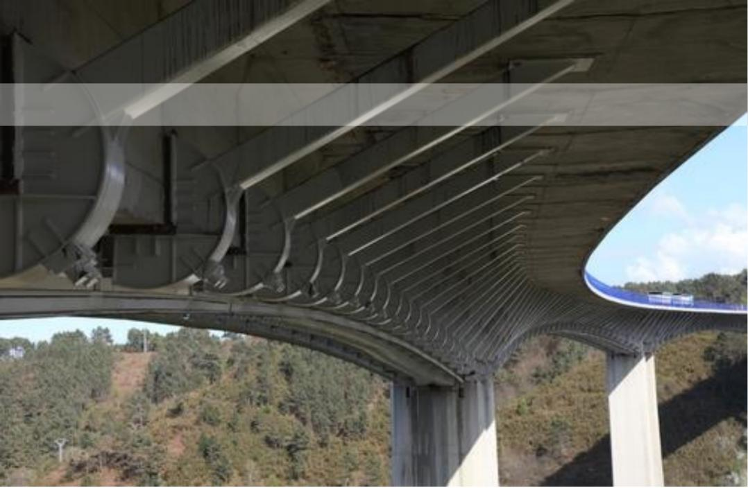
**Viaducto de San Pedro de la Ribera.** Con el viaducto en servicio, trabajos de ampliación del tablero de voladizos sucesivos de 750m de longitud y luces de 150m. Incluido en un tramo de 7km de la autovía A-8. Sistema de pretensado interior extradosado y balcones metálicos exteriores. Losa superior ejecutada con carro. Obra contratada con la UTE Cudillero para el Ministerio de Fomento en 2004. Se construyó en sólo 20 meses.
