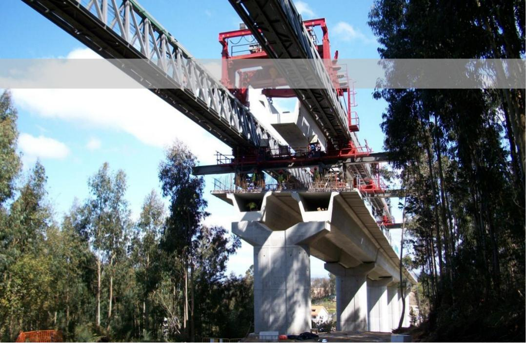
**Viaducto de A Ermida.** Infraestructura para autovía de 425m de longitud, ejecutado mediante lazador de vigas con vigas artesas prefabricadas de 2m de canto. Obra contratada con UTE Zapateira (Puentes, Azvi) para el Ministerio de Fomento en 2009.
