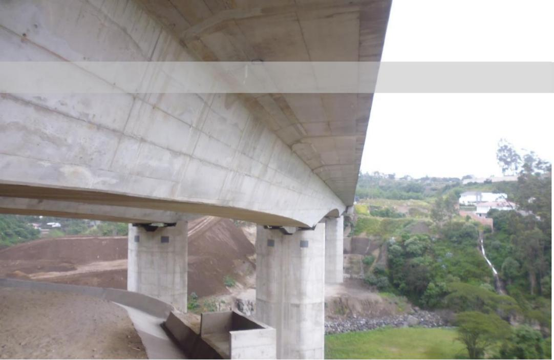
**Puente de San Pedro. Ecuador.** Infraestructura para carretera de 100m de luz en el vano central. Tablero de losa continua y canto variable ejecutada con cimbra. Apoyado sobre pilares específicos para soportar los lahares de una posible erupción del Volcán Cotopaxi. Junto con el puente de Chiche y el enlace de Puembo, está encuadrado en la autopista Ruta Viva. Contratada en 2012 con la EPMMOP de Quito. Ejecutado en 316 días.
