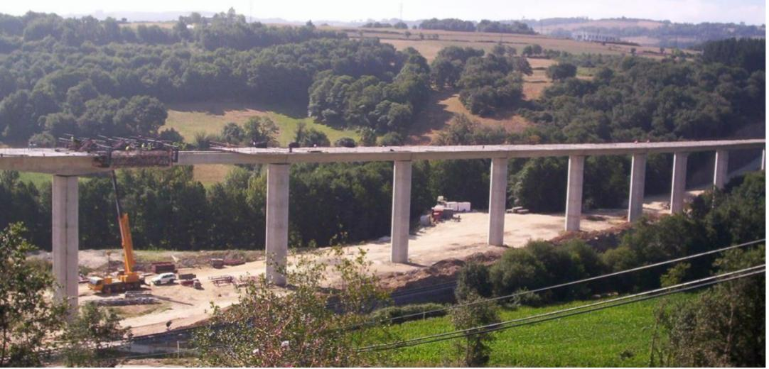
**Viaducto Río Pequeno.** Infraestructura para autovía con una longitud de 740m, conformado de vigas cajón prefabricadas de 1,85m de canto. Los vanos largos se ejecutan con vigas martillo de canto variable con postesado de continuidad. Losa ejecutada "in situ" con carro. Contratada con UTE Sarria (Hispánica, Construcciones Cortizo) para la Xunta de Galicia en 2007.
