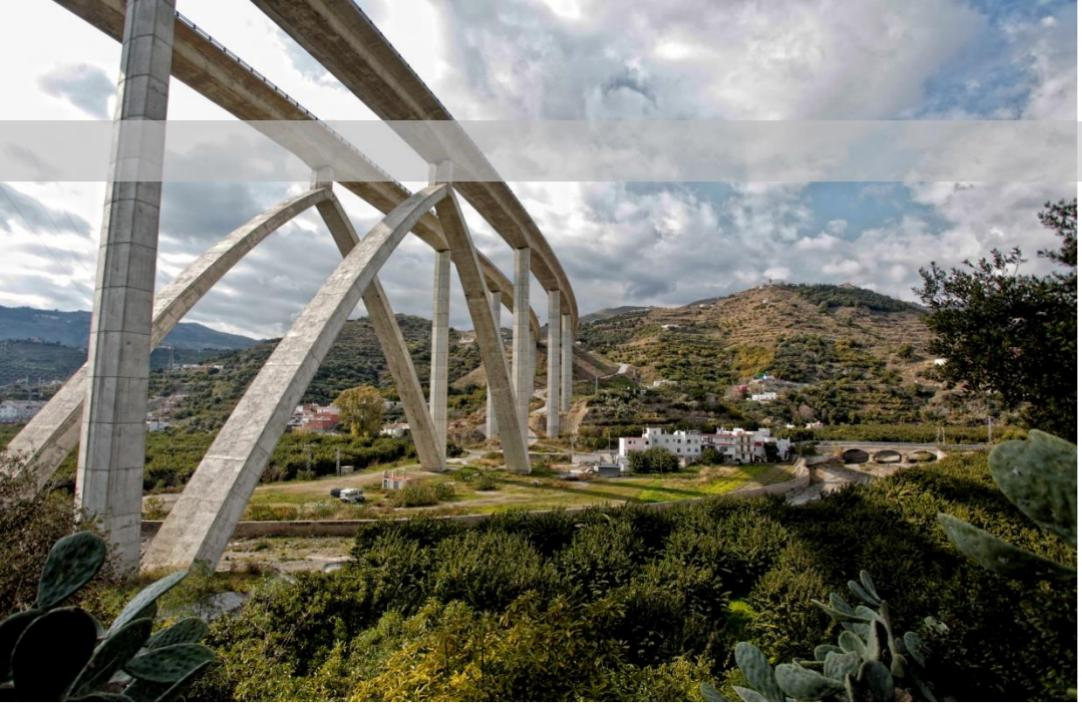
**Puente sobre el río Seco.** Infraestructura para autovía de doble tablero ejecutado con losa continua pretensada de canto variable, con 500m de longitud, ejecutado con arco apuntado central de 80m de alto, construido mediante el izado de semiarcos. Obra contratada con la UTE Herradura en 2004. Se ejecutó en 12 meses.
