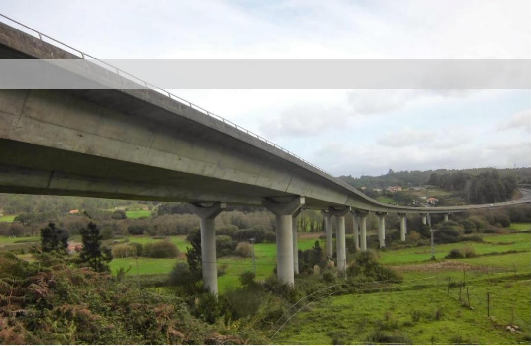
**Viaducto de Arteixo.** Infraestructura de doble tablero para autopista de 11m de ancho y 580m de longitud por calzada, distribuida en vanos de 50m, fue el primer viaducto con estas luces ejecutado por la empresa, con cimbra autolanzable. Obra contratada con Grupo Puentes para el Gobierno Autonómico en 1991. Se ejecutó en 13 meses.
