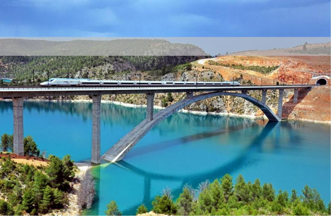
**Puente sobre el embalse de Contreras.** Infraestructura ferroviaria para alta velocidad, de 590m de largo sobre arco poligonal de 262m de luz y 130m de flecha; construido in situ por dovelas en voladizo, atirantadas a pilones metálicos provisionales. Contratada con la UTE Contreras (San José, Azvi) para Adif en 2008. Ejecutado en 23 meses. *Récord de Europa en mayor arco de hormigón por luz y esbeltez.*
