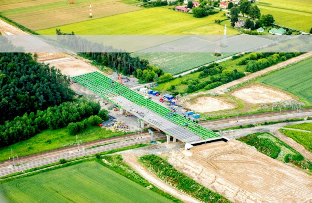
**Viaducto WS 20 Lublin. Polonia.** Infraestructura para autopista de doble calzada, con un tablero mixto formado por bijáscena de acero de canto variable, con losa de hormigón ejecutada in situ con encofrado colgado de barras de alta resistencia, y desencofrado por medios manuales por razones medioambientales. Contratado con Dragados en 2012, se ejecutó en 9 meses.
