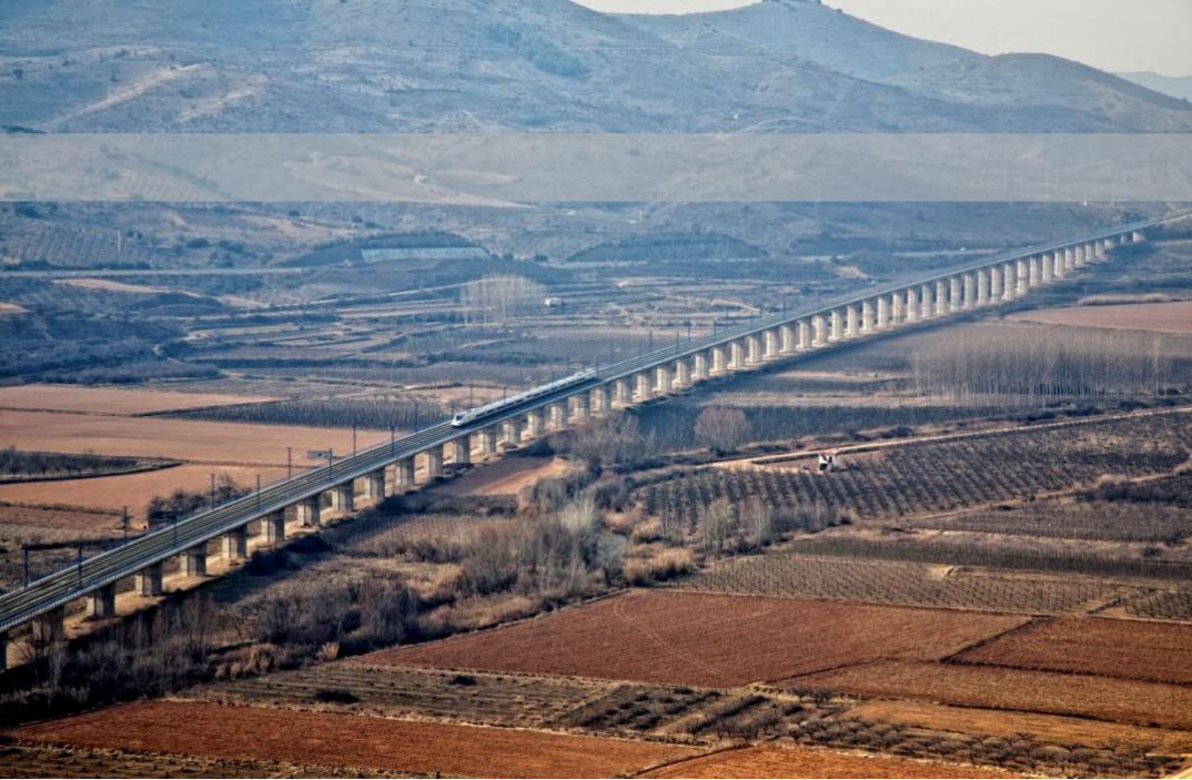
**Viaducto del Jalón.** Infraestructura ferroviaria de 2.200m de longitud (uno de los más largos de Europa), con pilares rectangulares huecos, ejecutados con encofrado auto-trepante, y tablero isostático e hiperestático, en distintos tramos, de hormigón pretensado ejecutado con cimbra autolanzable. Obra contratada con ACS para Adif en 1999. La duración de los trabajos fue de 13 meses.
