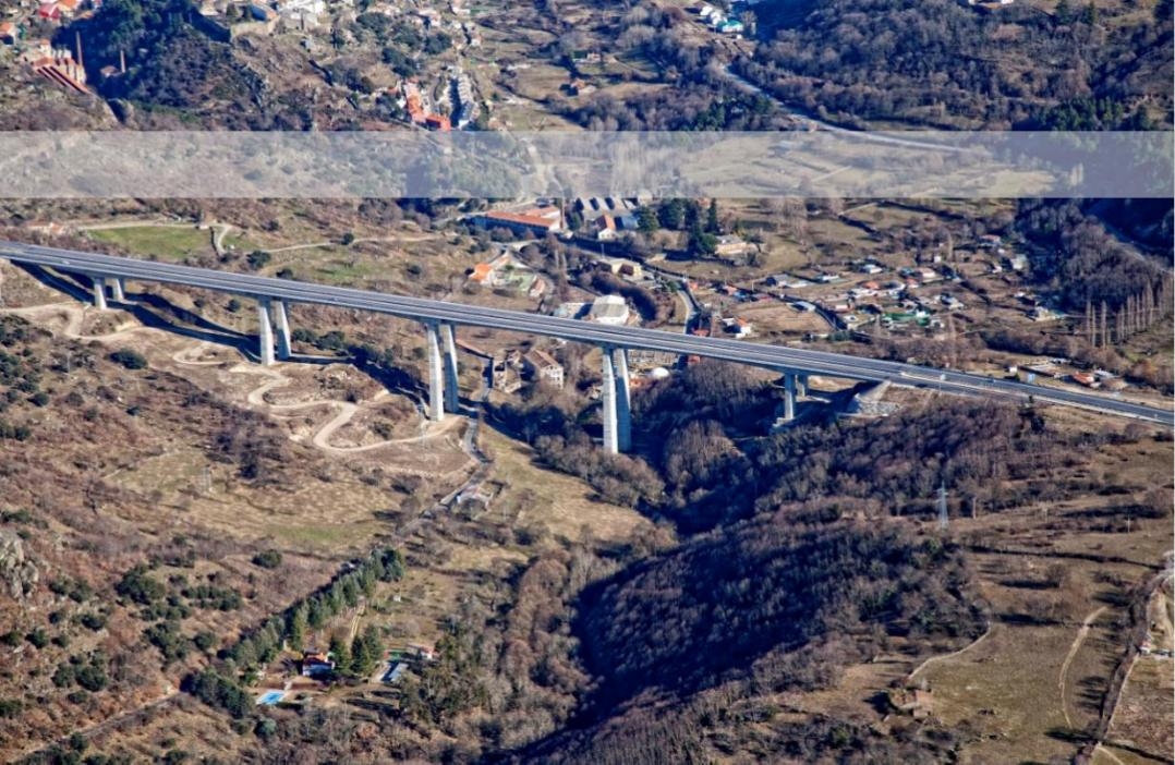
**Puente sobre el río Cuerpo de Hombre.** Infraestructura para desdoblamiento de autovía de 583m de longitud y 75m de alto. Tablero ejecutado en dos fases, primero los extremos con cimbra porticada al suelo, y después la zona central del puente mediante carros de voladizos sucesivos (canto variable. La losa superior se ejecutó con carro. Obra contratada con Azvi para el Ministerio de Fomento en 2007. La duración de las obras fue de 20 meses.
