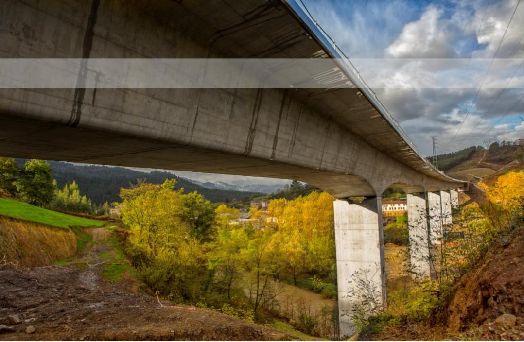
**Viaducto de Ibaizabal.** Infraestructura ferroviaria para alta velocidad de 394m de longitud. Tablero de viga cajón con luces de hasta 75m ejecutado cada vano en diversas fases. Pilares rectangulares huecos construidos con encofrado auto-trepante. Contratada con la UTE Amorebieta para Adif en 2012. La duración de las obras fue de 10 meses. Récord nacional de luz máxima en tablero ejecutado con cimbra autolanzable.
