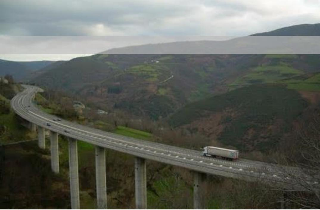
**Viaducto de Navas.** Infraestructura para autovía con ancho total de tablero de 27,6m y sus luces son de 50m. En primera fase se ejecutó el tablero con ancho de 9,5m con cimbra autolanzable, y en segunda fase se colocaron los jabalcones prefabricados y se ejecutó con carro del resto de losa. Contratada con la UTE Cabezón de la Sal (Sacyr, OHL) en 2000. La duración de las obras fue de 16 meses.
