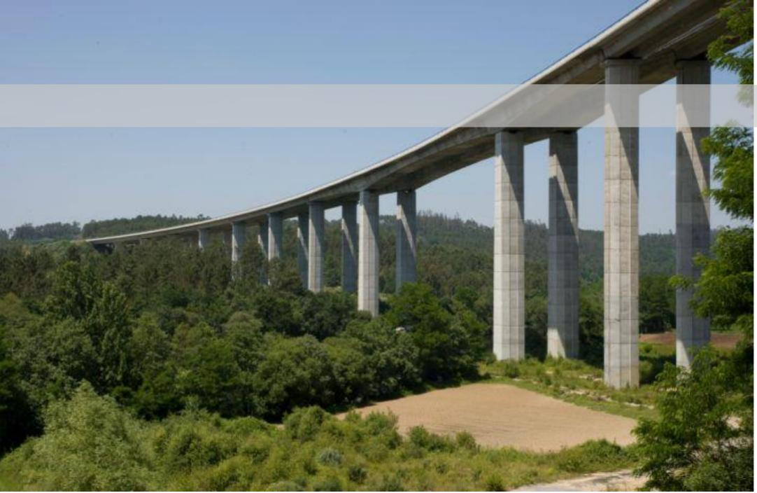
**Viaducto del Ulla.** Infraestructura para autovía de doble tablero con una longitud de 701. El tablero del vano central (110m) fue ejecutado mediante voladizos sucesivos, y los accesos con vigas prefabricadas tipo artesa. Apoyado sobre pilares octogonales construidos con encofrado auto-trepante. Obra contratada por la UTE Dozón (ACS, FCC, Ploder, OHL, Sacyr ) en 2001. La duración de los trabajos fue de 11 meses.
