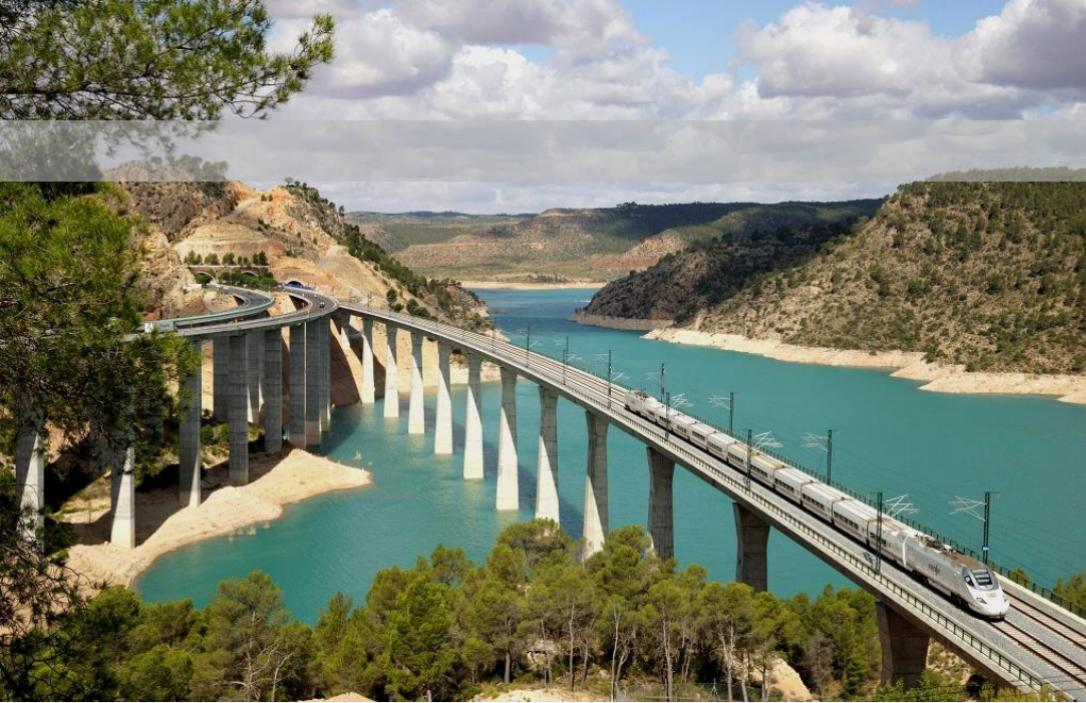
**Viaducto del Istmo de Contreras.** Infraestructura ferroviaria para alta velocidad de 832m de longitud, 66m de vano. Pilares de sección variable de hasta 69m de altura, construido sobre el embalse de Contreras. Cada vano se ejecutó en 2 semanas debido a las diversas fases de tesado. Fueron contratados con la UTE Azvi-San José para Adif en 2007. Se ejecutó en 20 meses.
