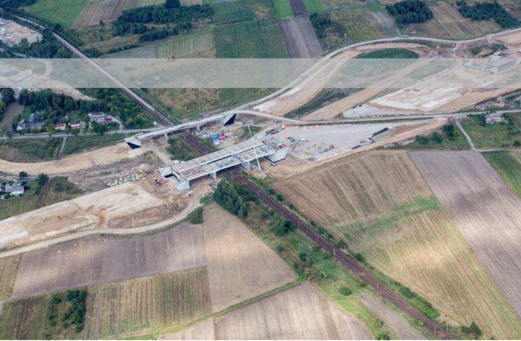
**Viaducto 5.20 Lublin, Polonia.** Infraestructura para la autopista S8, proyectada para salvar la vía del ferrocarril, en servicio, compuesta por dos puentes gemelos de ancho variable entre 19,3 y 23,4m y vano máximo de 37m. El tablero está formado multijácenas de acero de canto variable entre 1,95 y 2,55m y losa de hormigón ejecutada in situ. Contratado por la UTE Dragados, Pol-Aqua en 2012, se completó en 8 meses.
