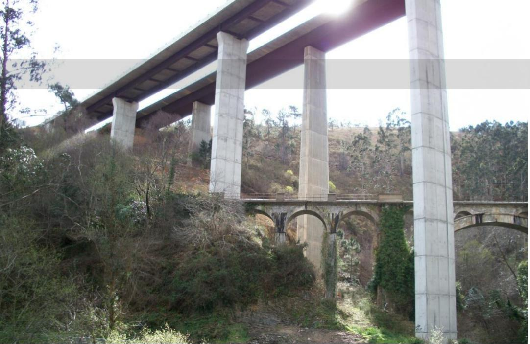
**Viaductos de Lindabarcas.** Obras englobadas en un tramo de la autovía A-8 de 7km de longitud junto con el viaducto de Albuerne. Viaductos singulares con pilares de hasta 50m de altura, con tablero mixto de bijáscena de acero colocada mediante empuje, y losa de hormigón ejecutada con carro. Obra contratada con el Ministerio de Fomento en 2004. Ambos viaductos se terminaron en un plazo total de 10 meses.
