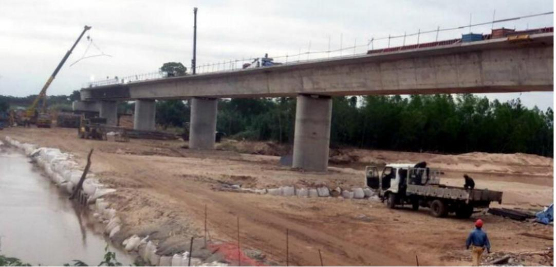
**Puentes sobre los ríos Piraí, Ichilo y Yapacaní.** Infraestructuras ferroviarias englobadas en el tramo Montero-Bulo Bulo, con 799m de longitud máxima, con 7,3m de ancho, y 2,6m de canto, tienen un vano máximo de 39m gracias a sistema de pretensado en los cuchillos de la cimbra que evita apoyos intermedios. Contratada en 2014 por Puentes infraestructuras para el Estado Plurinacional de Bolivia. Los tres puentes se ejecutaron en 15 meses.
