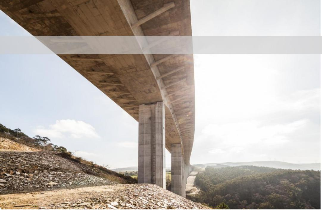
**Viaducto de Lindín.** Infraestructura para autovía de 757m de longitud, con tablero de 24m de ancho (doble calzada) ejecutado en dos fases: el núcleo, con cimbra autolanzable, y con carro autoportante la losa de hormigón sobre puentes prefabricados. Contratado con UTE Lindín-Mondoñedo (Ferrovial, Taboada) para el Ministerio de Fomento en 2010. La duración de las obras fue de 15 meses
