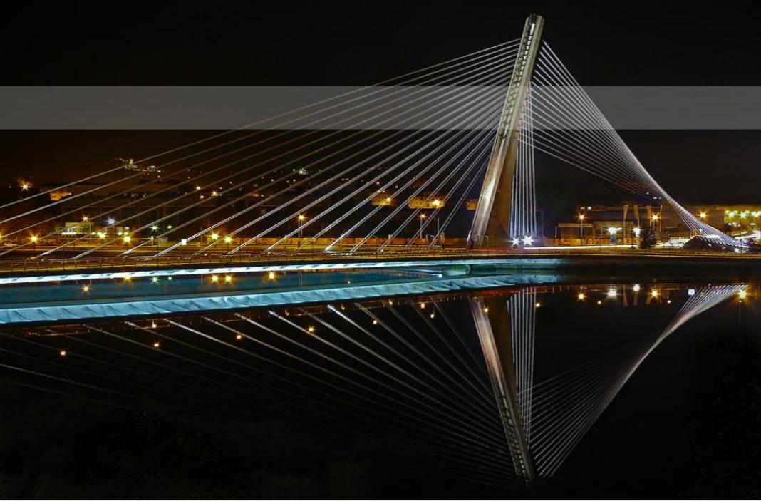
**Puente sobre el río Lérez.** Atirantado tipo arpa de 137m de luz, con pilono de hormigón de 58m de altura y gran esbeltez. Tablero de hormigón ejecutado mediante voladizos sucesivos. Obra contratada con Gobierno de Galicia en 1993. La duración de las obras fue de 28 meses. Mención especial en 1998 en los premios Estructuras Nobles de la Federación Internacional del Pretensado.
