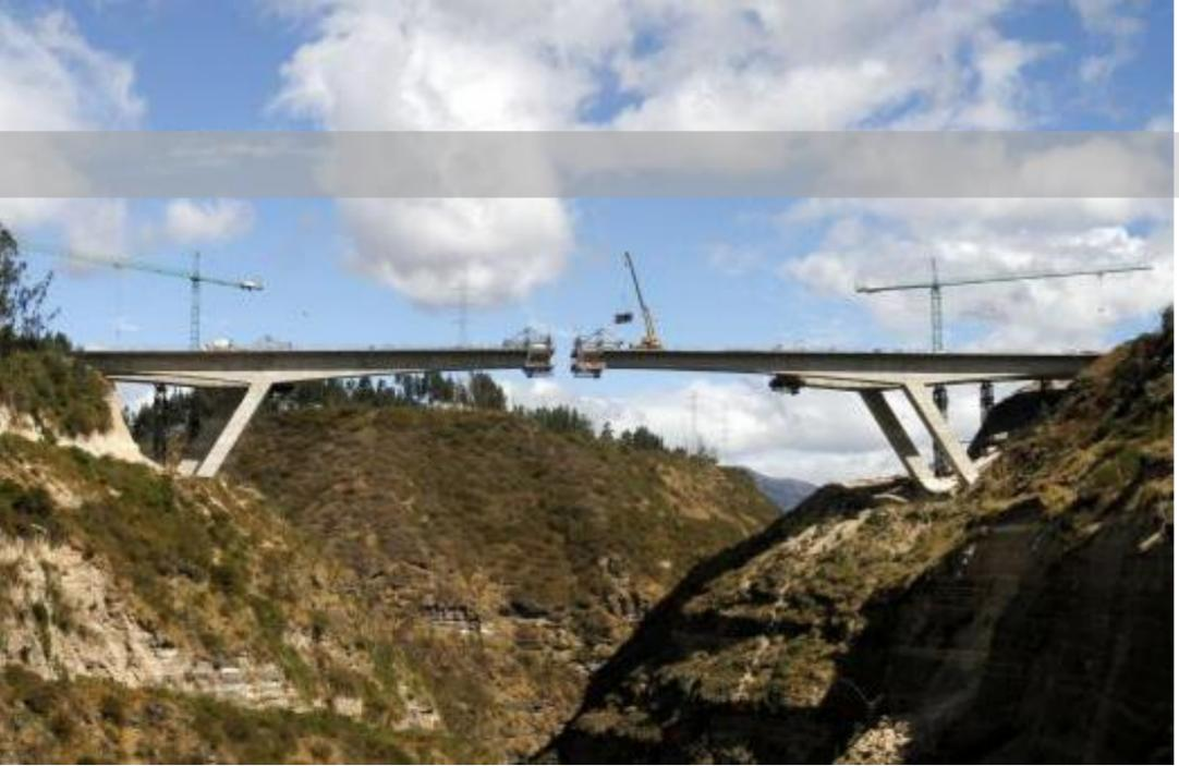
**Puente de Chiche. Ecuador.** Infraestructura para autopista de 210m de vano central, sobre una quebrada de 137m. Tablero de tres vanos: los laterales ejecutados sobre cimbra, y el central por voladizos sucesivos. Junto con el puente de San Pedro y el enlace de Puembo, está encuadrado en la autopista Ruta Viva. Contratada en 2012 con la EPMMOP de Quito. Plazo de ejecución de 14 meses.
