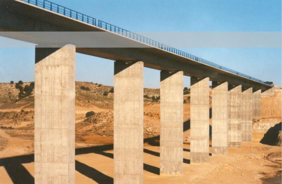
**Viaducto de Bujaraloz.** Puente de 371m de longitud y 2,5m de canto con vanos de 35m. Tablero en sección cajón ejecutado mediante el empuje del vano construido previamente en el parque habilitado al efecto. Contratado en 1.999 con la UTE OPC-Tecsa para el Ministerio de Fomento, se completó en 12 meses.
