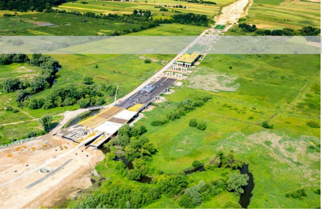
**Viaducto MS16 Lublin. Polonia.** Infraestructura para autopista de 36.675m<sup>2</sup> de superficie, con ancho variable y ramales de acceso incorporados. Tablero mixto formado por bijáccena de acero con losa de hormigón ejecutada in situ con encofrado colgado de barras de alta resistencia y desencofrado por medios manuales por razones medioambientales. Contratado con Dragados en 2012.
