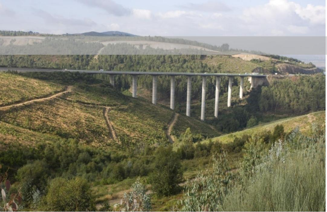
**Viaducto de Santa Marta.** Infraestructura para autovía de 410m de longitud. Primero de los cuatro viaductos fungiformes construidos por la compañía. Pilares octogonales para sostener cada seta de 27 por 37m de losa, en hormigón armado. Construido por fases sucesivas con una cimbra autolanzable específica; con un ciclo de 15 días por vano. Obra contratada con la UTE Monterrey en 1997. La duración de los trabajos fue de 14 meses.
