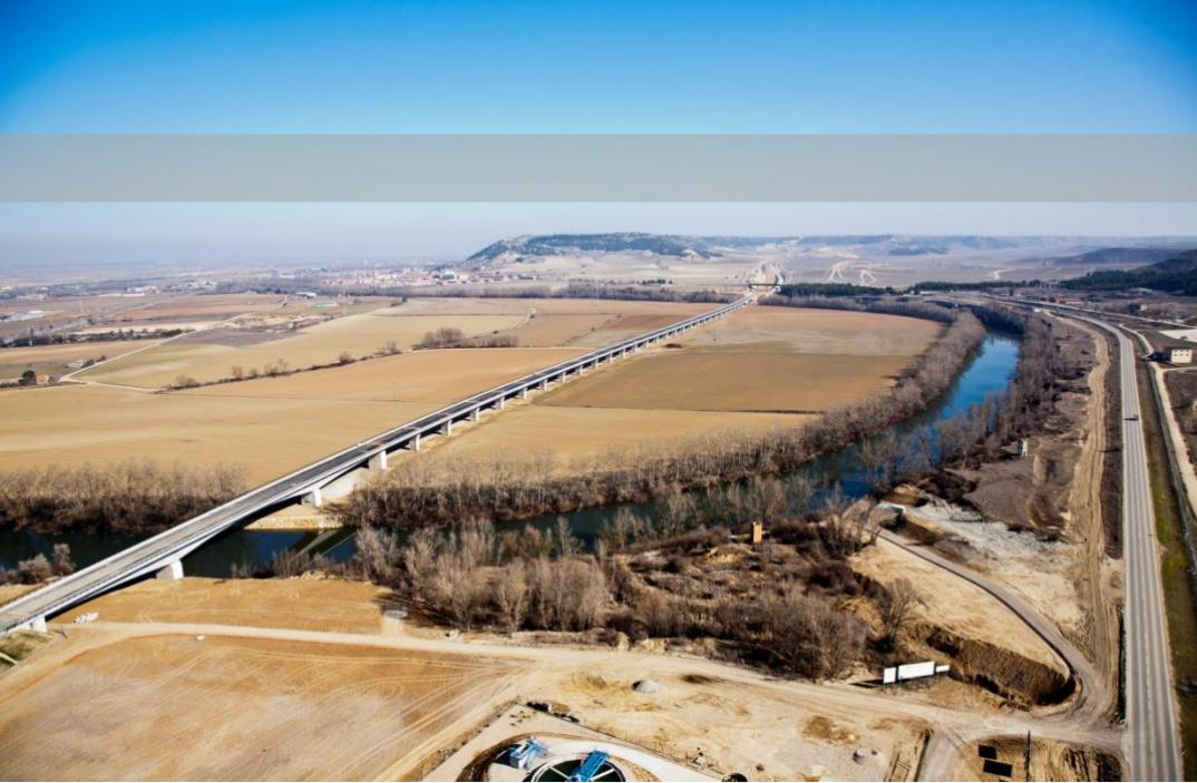
**Puentes sobre el río Pisuerga.** Englobado en un tramo de 5,3km de infraestructura ferroviaria para alta velocidad que forma parte del Nudo Norte de Valladolid. Viaducto que cruza el río Pisuerga con dos puentes de 185 y 132m de longitud, ejecutados por voladizos sucesivos con canto variable entre 3 y 6m. Fue contratado con Puentes Infraestructuras para el Ministerio de Fomento (Adif) en el año 2009 y ejecutado en 22 meses.
