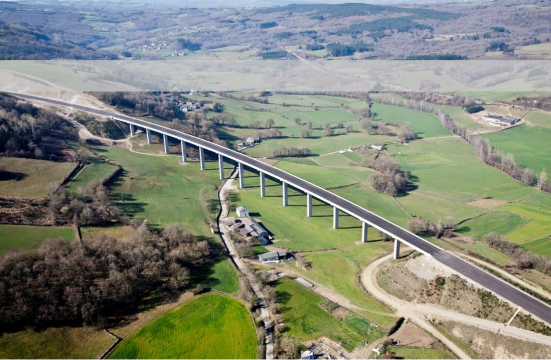
**Viaducto de Albán.** Infraestructura para carretera de doble calzada de 14,3m de ancho de tablero y 531m de longitud, ejecutado con vigas prefabricadas doble T de 2,3m de canto, montadas con grúa. Contratado en 2009 con la UTE Noceda. Se ejecutó en 6 meses.
