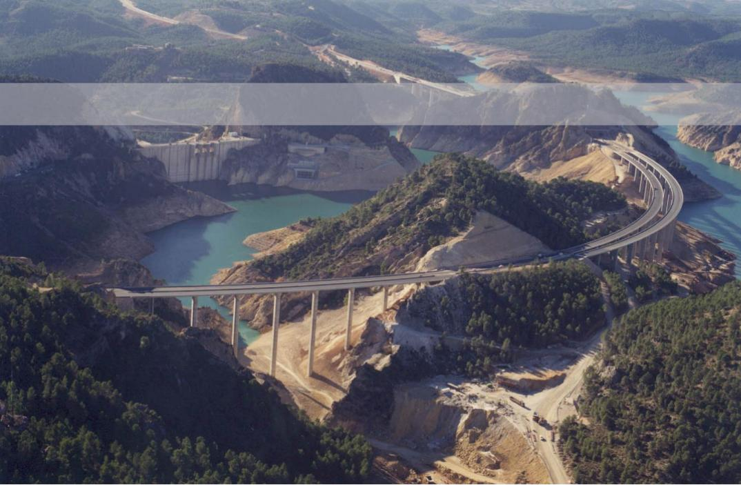
**Puente del barranco de la Vid.** Infraestructura para carretera de 298m de longitud, con tablero de 28m de ancho y canto variable ejecutado con losa armada mediante vanos sucesivos de 27 por 37m con cimbra autolanzable específica fungiforme con un ciclo de 15 días por vano. Contratada en 1998 por la UTE Nacional III (OCP Construcciones, Auxini, Firmecivil) para el Ministerio de Fomento. Fue ejecutada en 11 meses.
