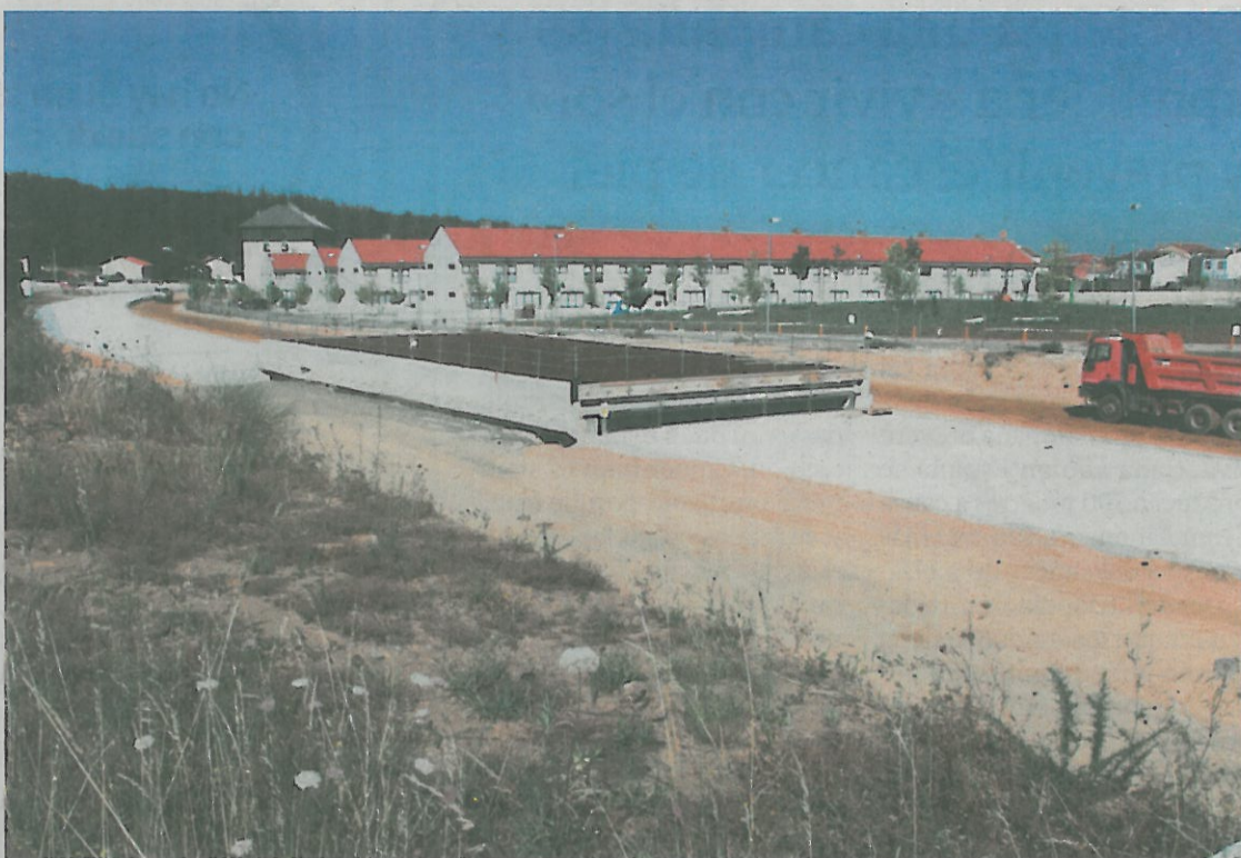
El primer tramo de la plataforma que cubre la vía del AVE ya es bien visible junto a las urbanizaciones.
