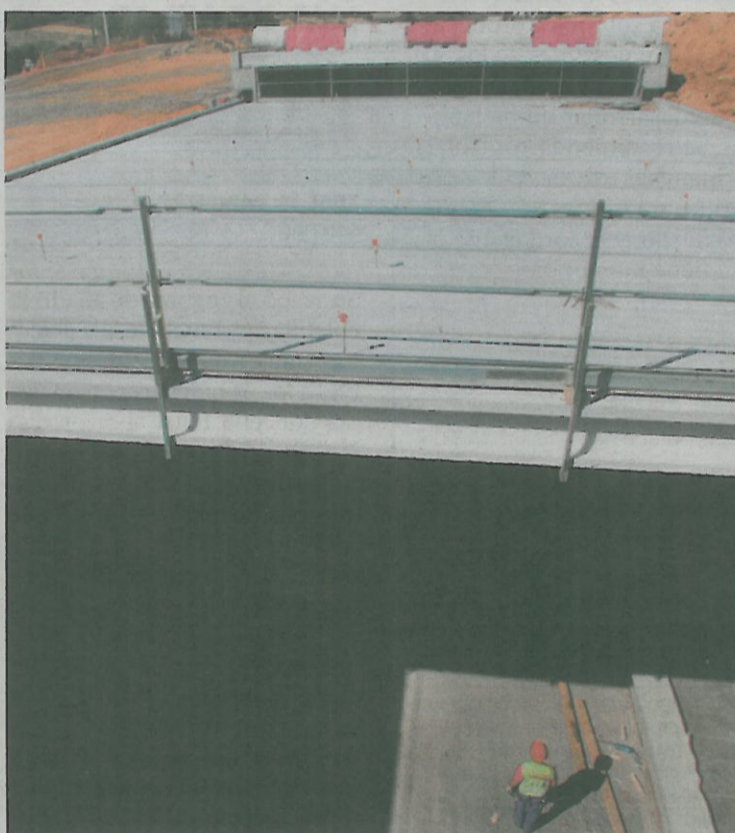
El falso túnel encarece la obra en diez millones de euros. P. RODRÍGUEZ
